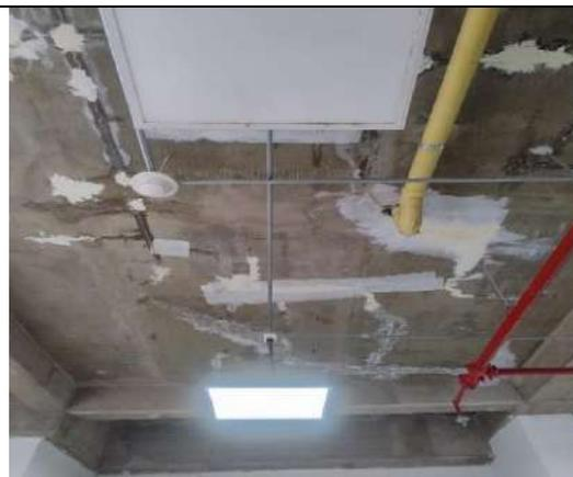
Riesgo de humedad por en caso de que se rompa una tubería, contaminación de polvo por el techo
